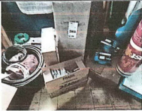
Foto 1. Ingreso de Materiales nuevos de Electricidad
